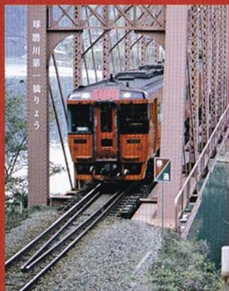
球磨川第一橋梁
